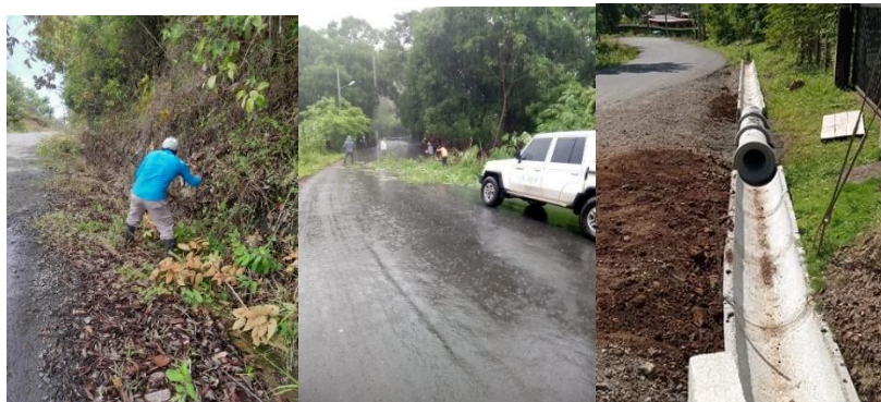
Descuaje, corta de árboles y colocación de media caña
