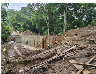
Construcción de Puente Zulay
