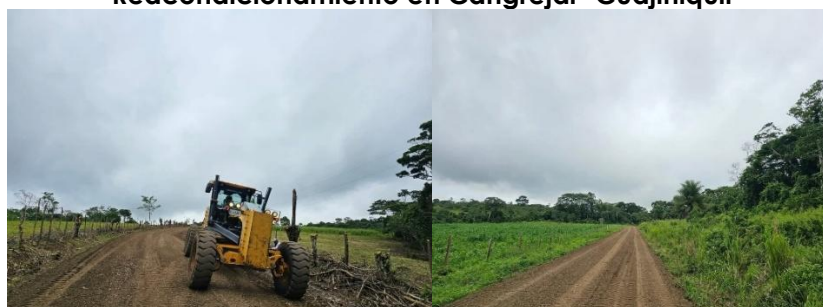
Conformación de caminos Asentamiento Valle Real y Orosí
