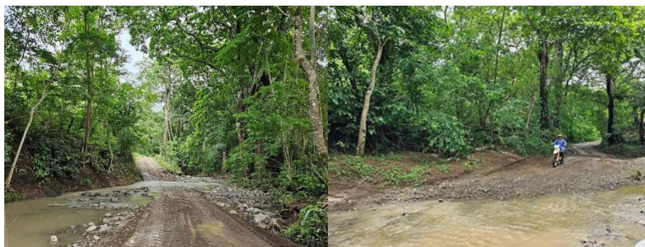
Rehabilitación de caminos El Cacao- Monte Plata
