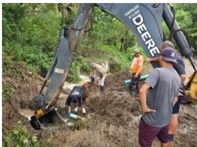
Coordinación con ASADA Cuajiniquil para rehabilitación de acueducto
