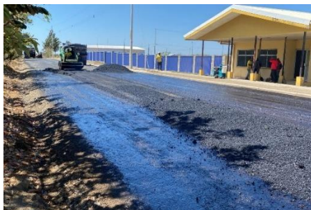
Colocación de asfalto calles Barrio Irvin-La Cruz
