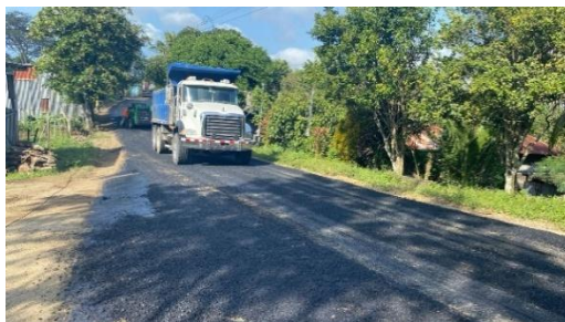
Colocación de asfalto camino Guapinol
