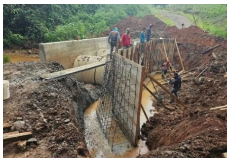
Construcción de alcantarilla en camino La Yegua- Santa Cecilia
